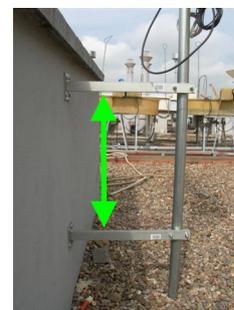
*Instalación sobre pared con apoyo en suelo*
